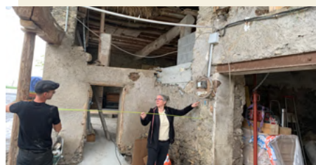
Travaux à la ferme Charpin à Saint-Pierre-de-Soucy, en Savoie.
