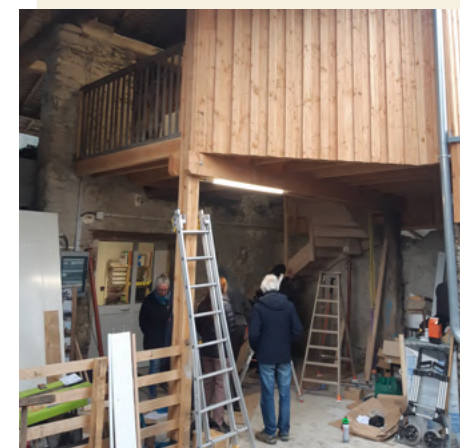
Travaux à la ferme de Flaceleyre à Vorey, en Haute-Loire.
