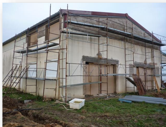
Aménagement d'un logement sur la ferme de la Briquetterie en Essonne.
